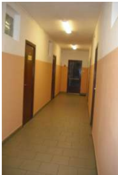
Chodba po rekonstrukci
