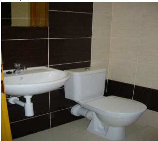
Toaleta po rekonstrukci
