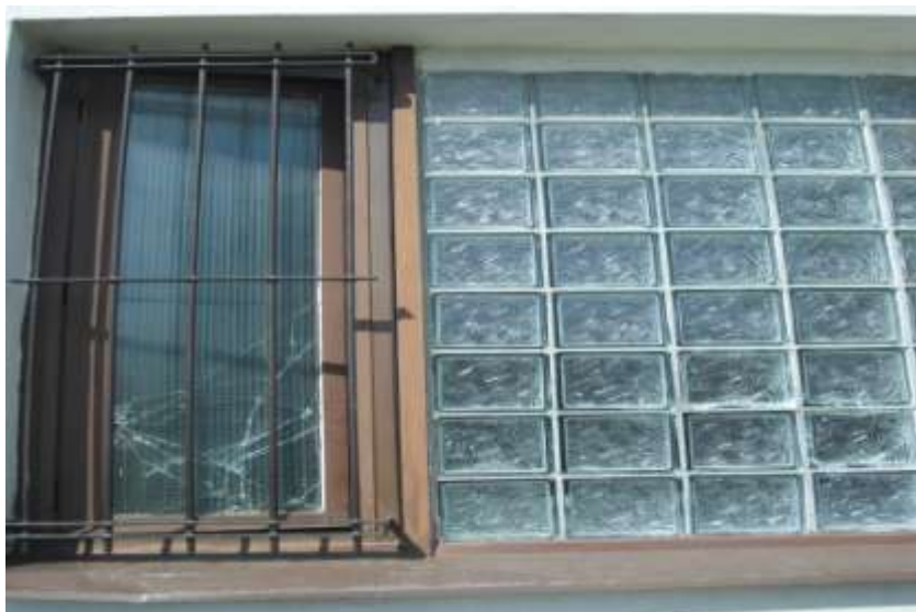
Okno před rekonstrukcí
